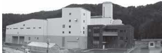
稼働に向けて建設工事が進む丹波市クリーンセンター
