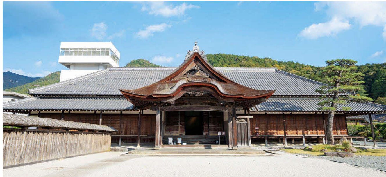
創建当時は、東西130m、南北158mという広大な敷地に御殿や庭園が設けられていました。
