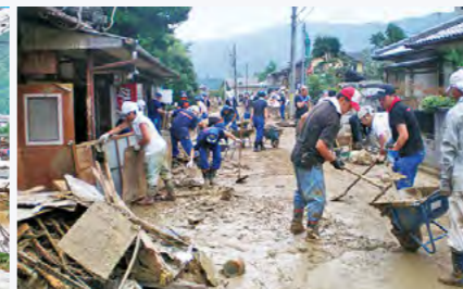
消防団やボランティアによる泥出し作業(前山地区)
