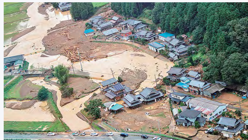
土石流により橋脚部分で流れがせき止められ氾濫した徳尾川(市島町谷上)
