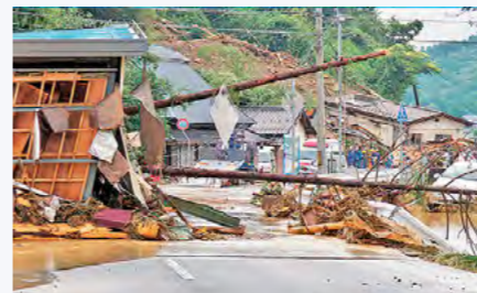
土石流により道に押し出された建物(前山地区)
