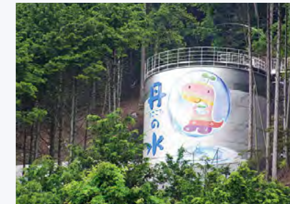
山の中腹にある「市辺配水池」。浄水場で処理された水を貯め、自然の落差を利用して各家庭や事業所などに供給しています。
