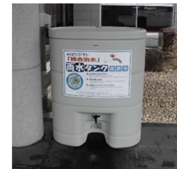
雨水貯留タンクの設置例 貯水量200ℓ (丹波市役所山南支所)
