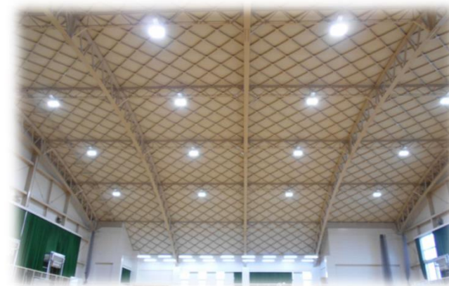
LED化された体育館の照明
