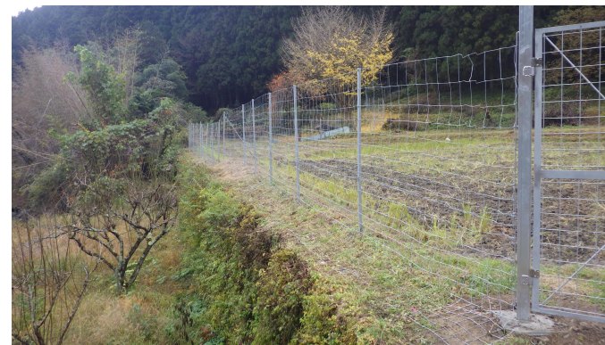
山裾に設置された金属柵
