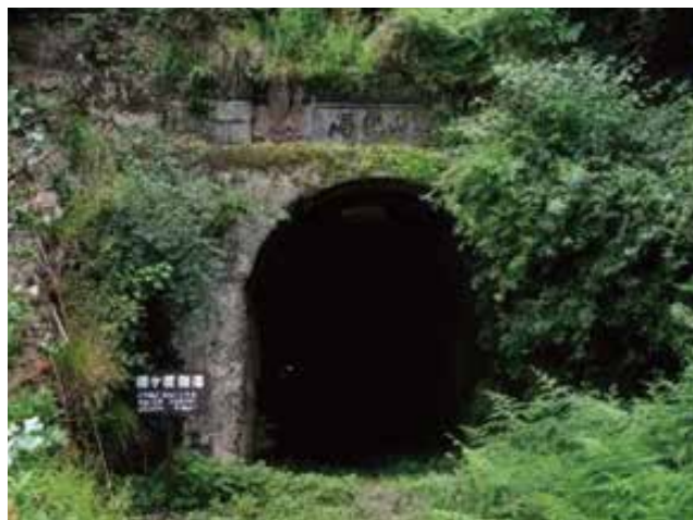
写真 鐘ヶ坂峠 明治のトンネル
