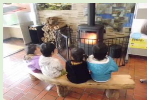
本庁舎に設置している薪ストーブ
