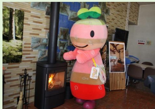
本庁舎に設置している薪ストーブ
