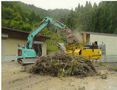
破砕機へ投入
