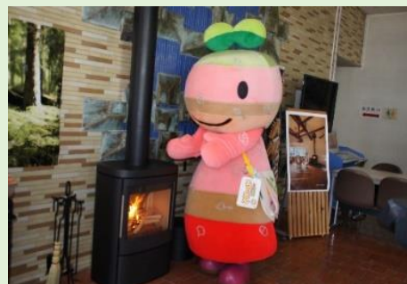
本庁舎に設置している薪ストーブ
