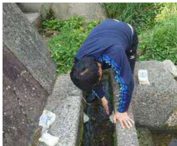
水路の目地補修
