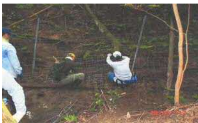
鳥獣害防護柵の点検・補修
