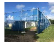
防風ネットの設置
