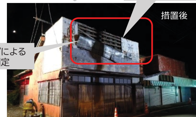
外壁の一部切断
