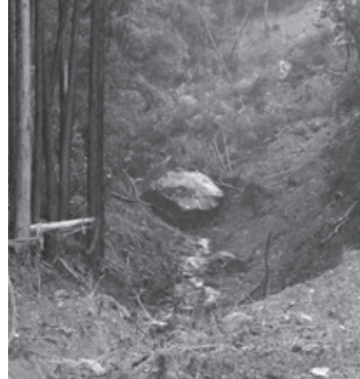
崩落の危険がある巨石（市島町徳尾）。ワイヤで固定し、砂防ダムを作る計画です
