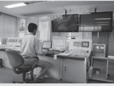
母坪浄水場(柏原地域)にある中央監視システムで市内の水道施設の監視を行っています
