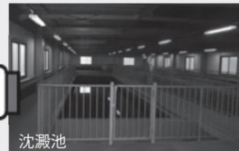
沈澱池で浮遊物を取り除きます。その後、塩素を注入することによって、マンガンを酸化させます
