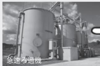
酸化したマンガンを急速ろ過機のマンガン砂に吸着させることによって、マンガンを除去します
