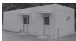
神池加圧ポンプ場外観
