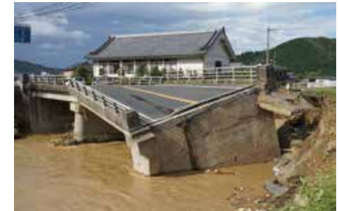
崩壊した国道175号にかかる八日市橋（市島町上竹田）
