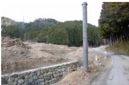
流木を撤去し、応急復旧された河川（市島町上鴨阪）
