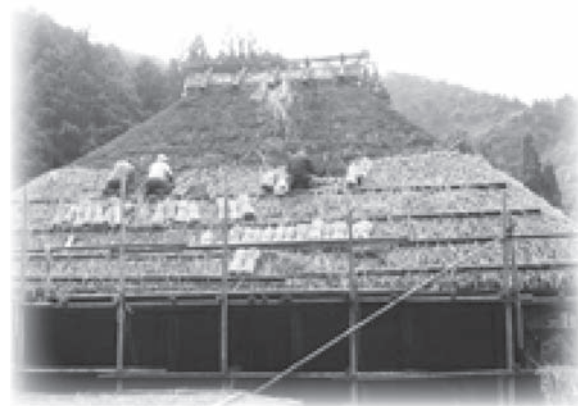
山本薬師堂（県指定文化財／山南町山本）屋根差し茅工事
