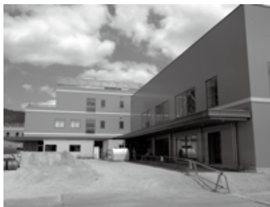
ミルネ建設現場
