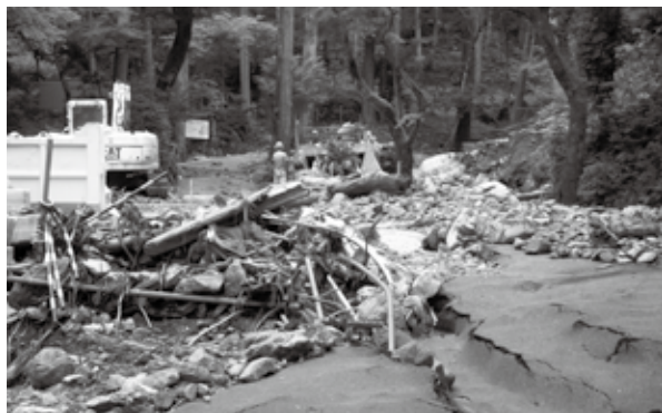
①平成 30 年 7 月豪雨で土砂に埋まった道路
