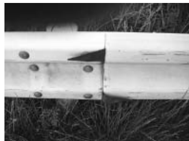
ガードレールに付着した金属片
