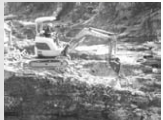
静かな渓谷にパワーショベルの振動音が鳴り響く。岩盤の表面が土煙をあげながらゆっくりとはがれていく。（1月25日岩盤除去作業開始）
