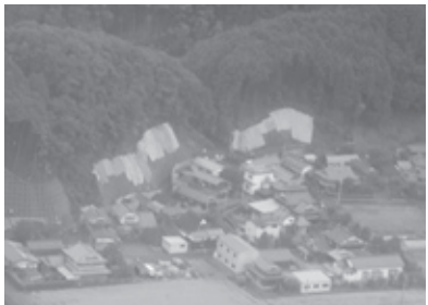
市内各地で土砂崩れなどの被害が発生しました。写真：氷上町稲畑地内
