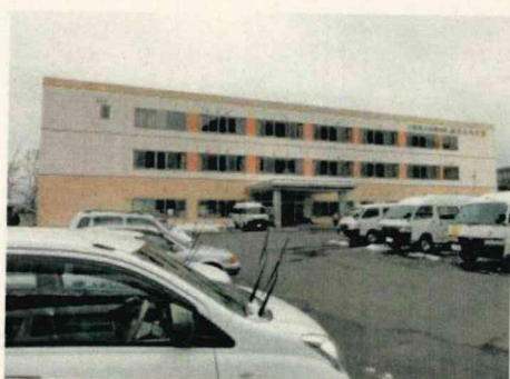
受水槽に給水を行った介護老人保健施設『ほほえみの里』 (3月12日撮影)
