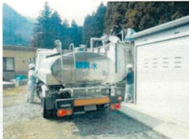
『ケアプラザおおつち』の受水槽 に給水を行っている様子 (3月31日撮影)
