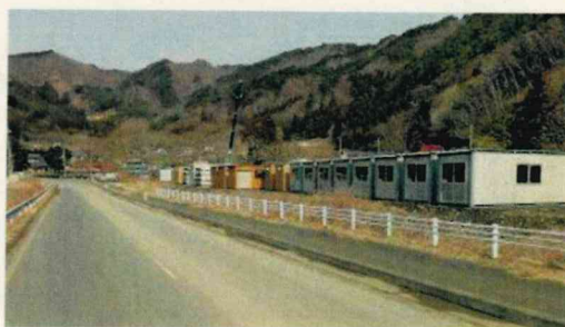
大槌町内に設置され始めた仮設住宅 (3月25日撮影)
