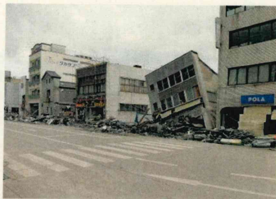
1階部分が崩れてしまった建物 釜石市内(3月23日撮影)
