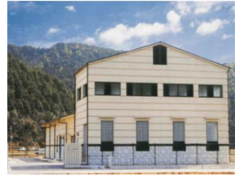
棧敷浄水場 (H12 年度建設) ・浄水能力 1460m 3 /日
