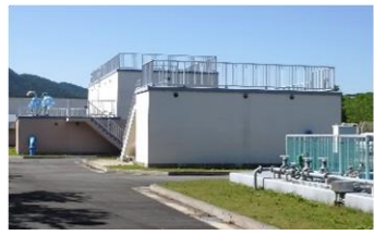
氷上中央浄水場 (H24 年度建設) ・浄水能力 4740m 3 /日
