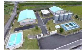
氷上南浄水場 (H23 年度建設) ・浄水能力 3340m 3 /日
