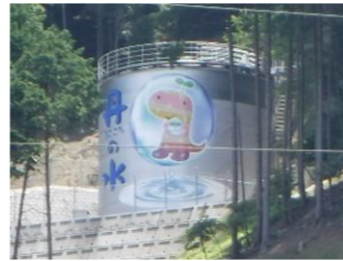
市辺配水池 (H25 年度建設) ・容量 700m 3
