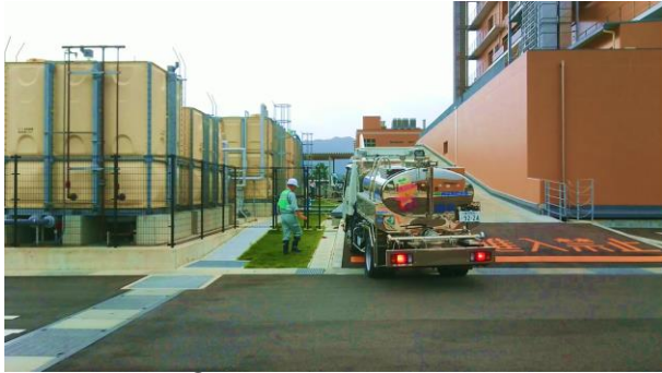
給水班②の給水車が現場に到着した様子
