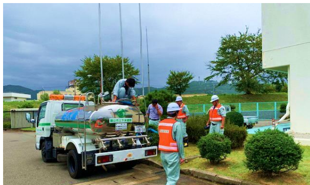
丹波篠山市の給水車に充水作業をしている様子
