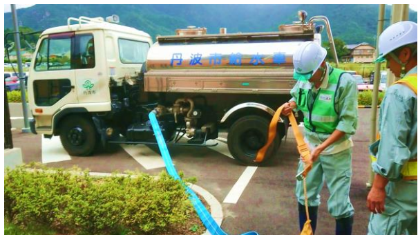
充水作業を行うにあたり、安全帯を装着している様子①
