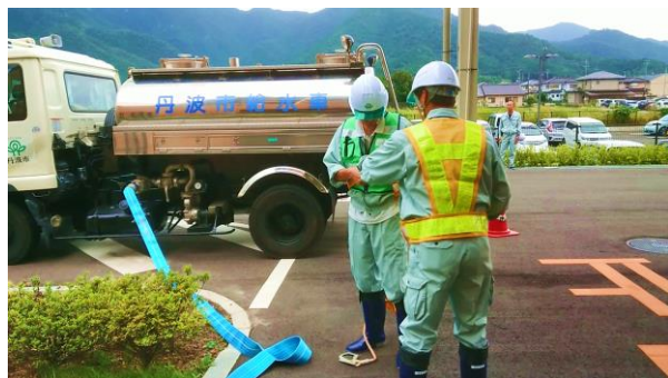
充水作業を行うにあたり、安全帯を装着している様子②
