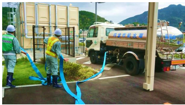
給水車から受水槽への充水を行う準備をしている様子②
