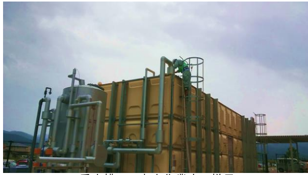
受水槽への充水作業中の様子
