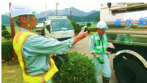
充水する水道水の残留塩素濃度を確認している様子②
