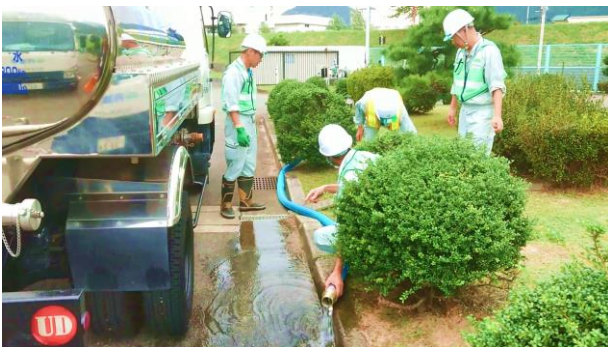
充水する水道水の残留塩素濃度を確認している様子③
