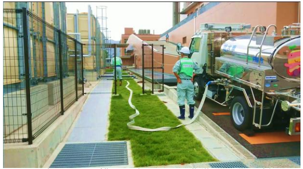
給水車から受水槽への充水を行う準備をしている様子
