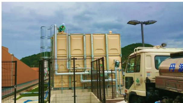
受水槽への充水作業中の様子
