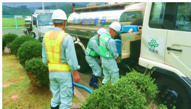
場内の消火栓から給水車へ充水する準備している様子②
