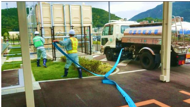
給水車から受水槽への充水を行う準備をしている様子①
