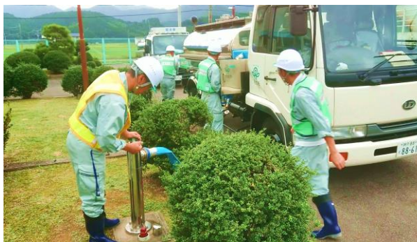
場内の消火栓から給水車へ充水する準備をしている様子
