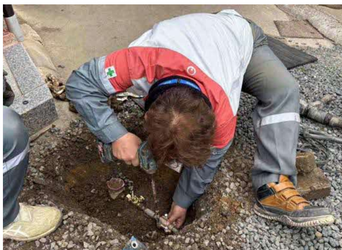
○包括業務受託者による直営修繕の様子
