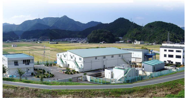
柏原地域の水道を支える浄水場。老朽化と設備の劣化が進んでいる。
