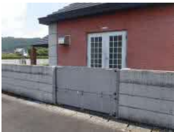
氷上東浄化センターの止水板設置状況
