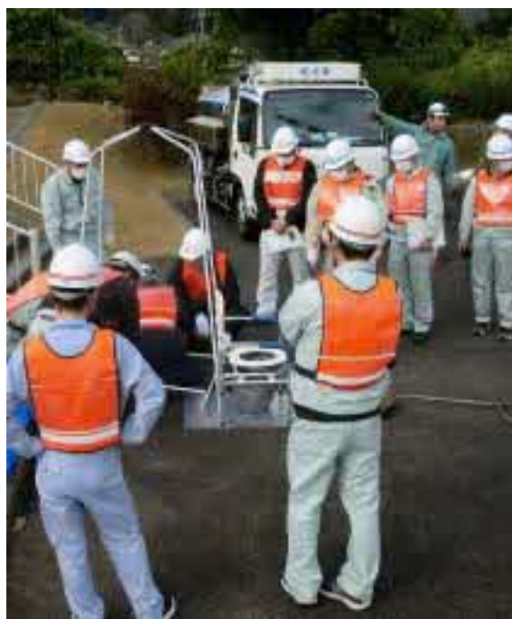
災害訓練におけるマンホールトイレ設置のようす
