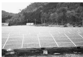
△農地転用（1.8ha）で設置された大規模な太陽光発電設備
