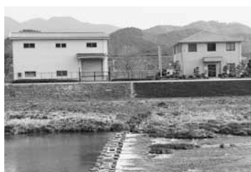
△兵庫県の救急内水ポンプ基地(左)と丹波市水防センター(右)
