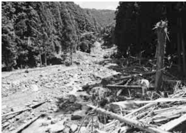
△崩壊した県道沼市島線（氷上町沼側）
