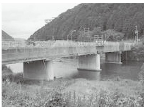
△耐震補強改修工事中の県道「山崎橋」
