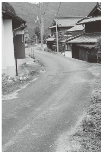
△地元要望が強い道路改良工事 (阿草地内)
