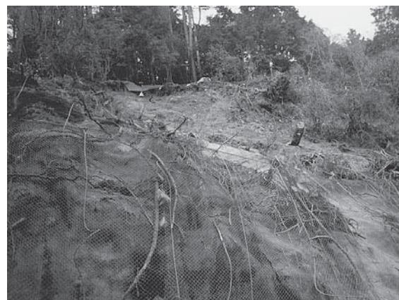
△山地崩壊の現場
