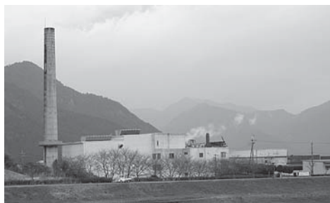
△「稼働中のストーカ式焼却炉」
