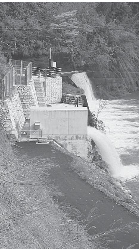
▲②小水力発電所
