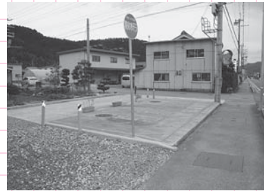
△地下式防火水槽
