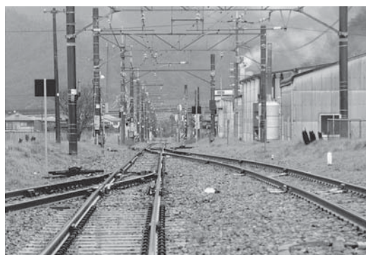
△高速化された鉄道
