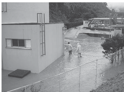
△浸水した東部雨水ポンプ場
