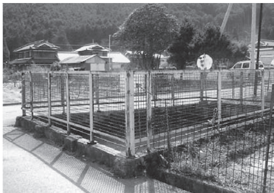
△改修される防火水槽
