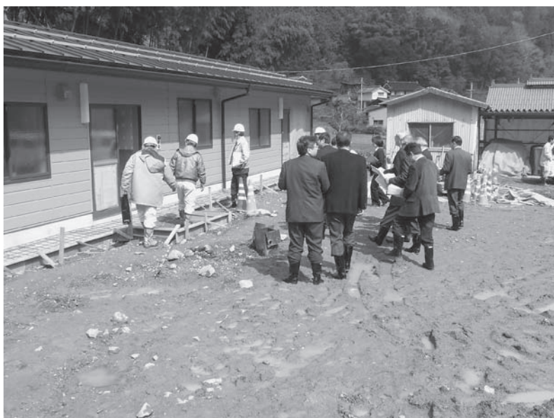
△建設中の稲土市民農園休憩施設
