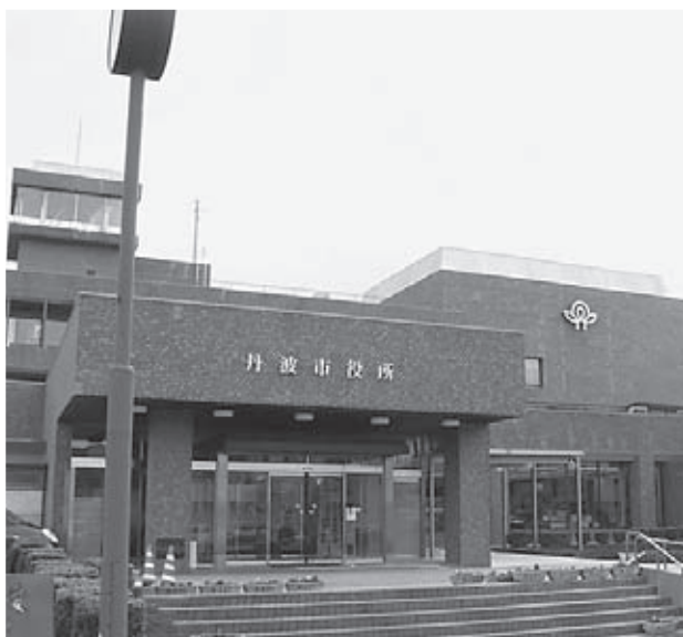
△本庁舎建設を
