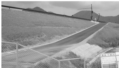
△封鎖された昇降口
