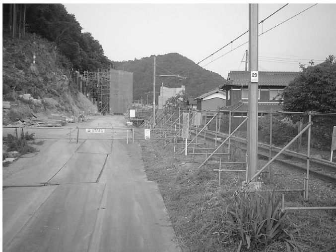
△建設が進む高架工事
