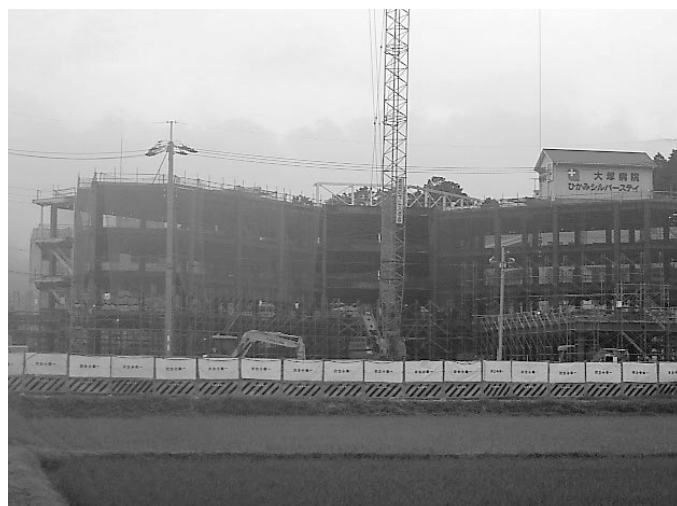
△建設が進む市内の医療法人
