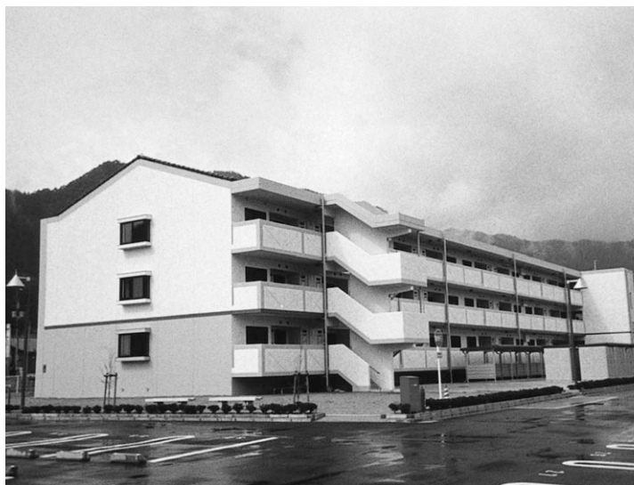
△若者定住へ期待……市営住宅
