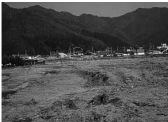
△工事が進む石生駅西土地区画整理事業
