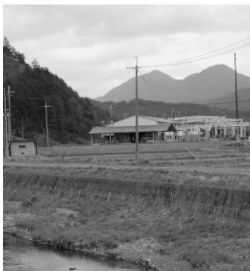
△建設が始まった自動車解体工場。手前は竹田川
