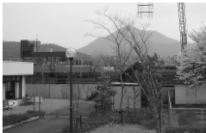
△建設中の青垣町民センター
