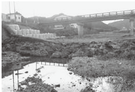
△和太大橋上流、京橋付近(大型土壌、土砂止め部分)
