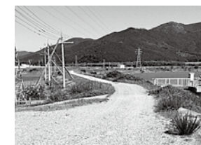
整備により魅力 UP する河川管理用通路
