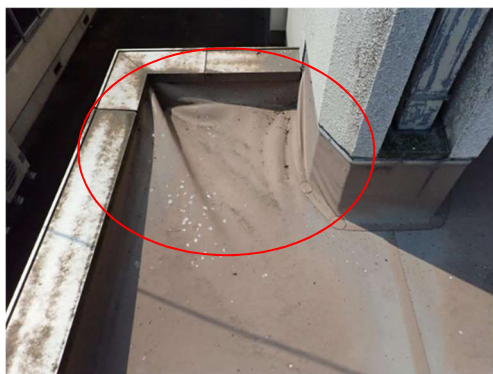
D 評価：シート防水のしわ
