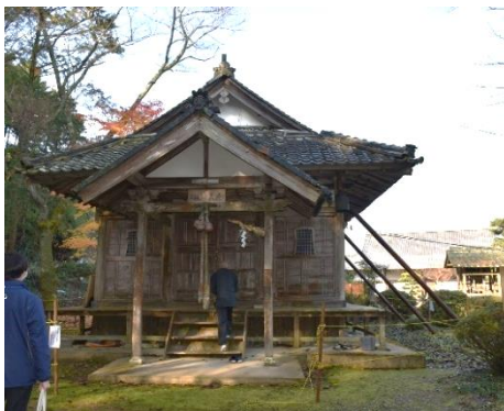
観音堂正面（南東面）
