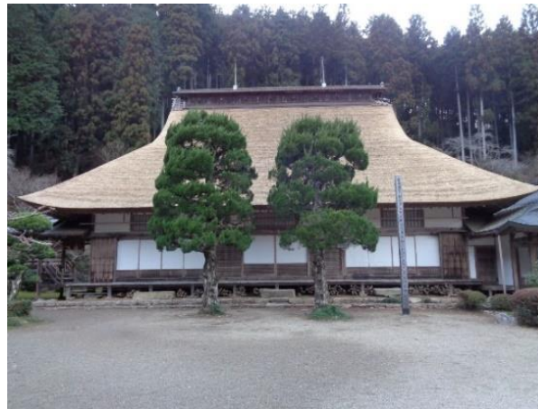
慧日寺方丈東面茅葺替等
