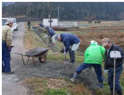
工事の直営施工
