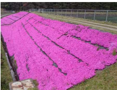
ため池の堤体ヘシバザクラの植栽
